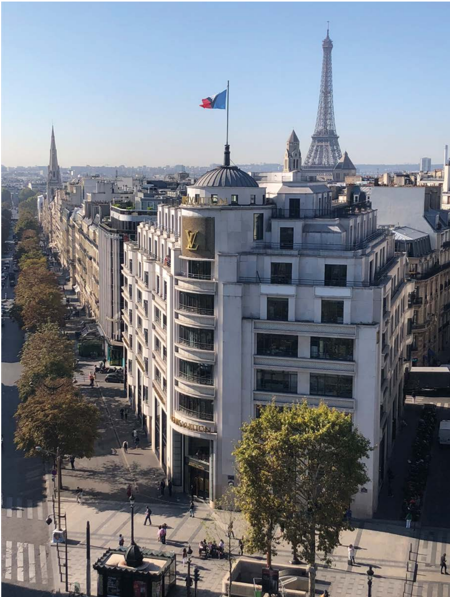
101 Champs-Élysées, réhabilitation lourde d'un immeuble de style Art Déco, classé Monument Historique
