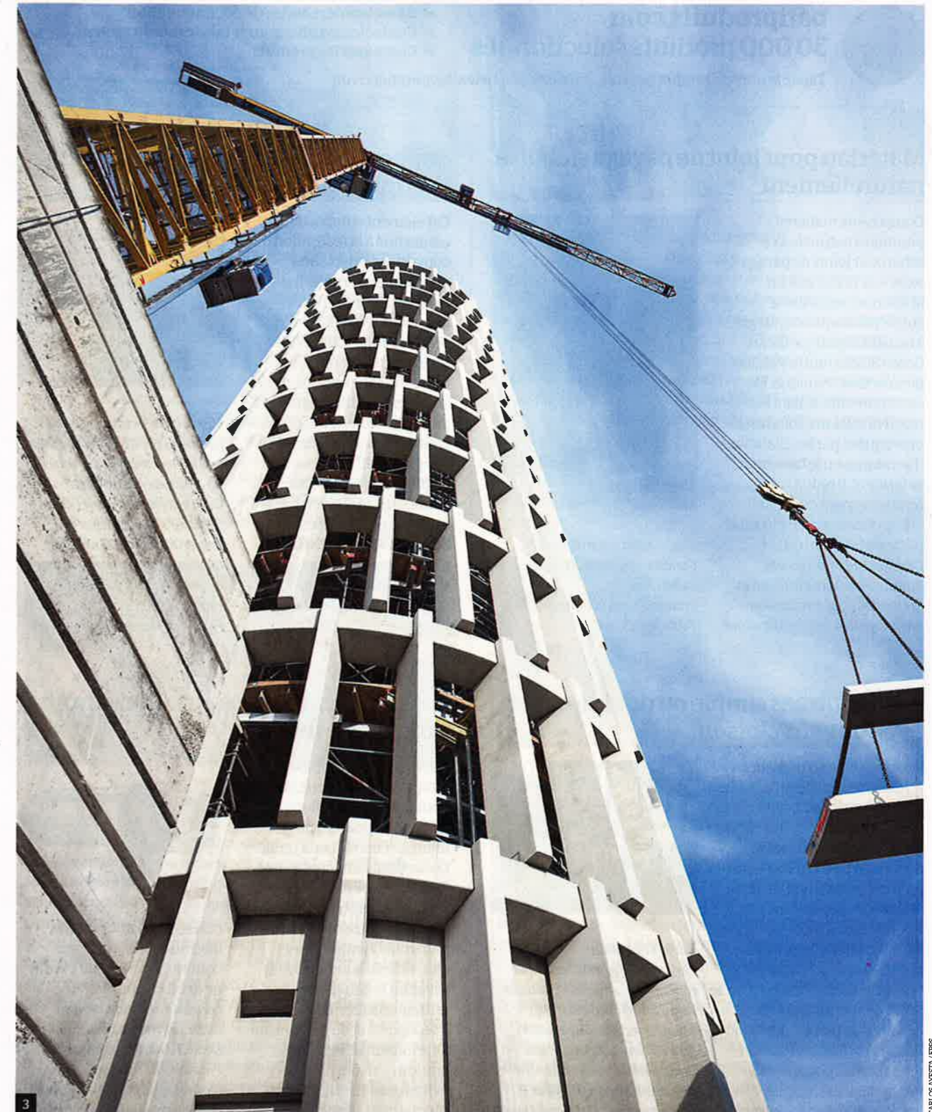
1 - Des tiges boulonnées en attente dans une poutre annulaire. 2 - Schéma de l'assemblage des poteaux aux poutres avec les connexions Peikko. 3 - La tour radar de Saclay (Essonne) consiste en un fût cylindrique de 57 m de haut et de 13,4 m de diamètre, composé de 308 claires-voies.
